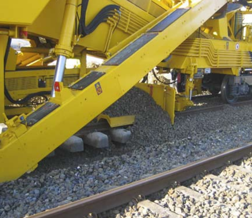
▲ Remise en voie du ballast
